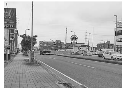
国道16号 この下でトンネル掘削されている
