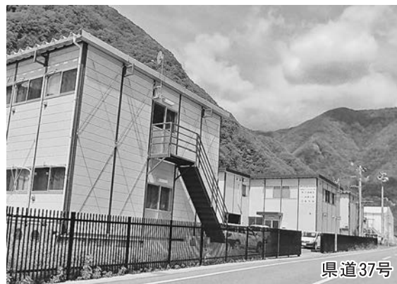
施工担当JVの事務所・作業員宿舎
