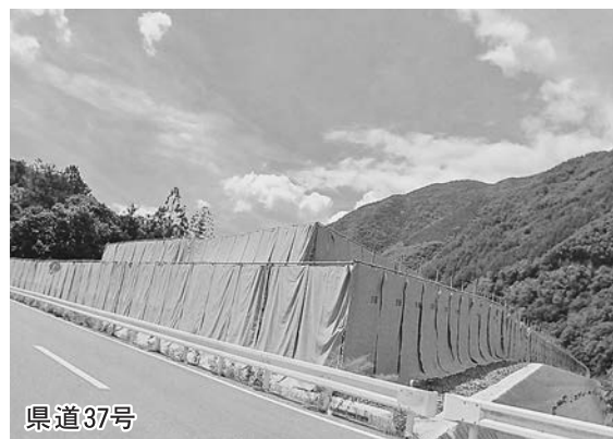
トンネル工事発生土置き場
