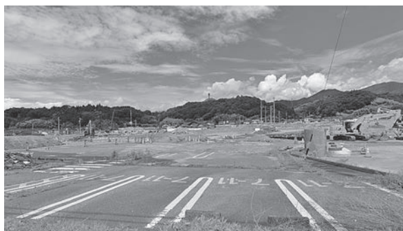
本格工事が開始されるリニア駅前広場予定地
