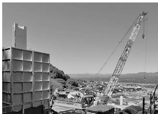
風越山トンネル立坑工事現場（北条上段） ここからシールドマシンが発進
