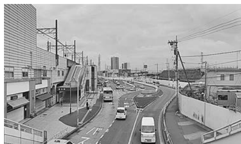
相模原市橋本駅とリニア神奈川県駅工事現場 右土嚢の箇所が「さがみはらリニアひろば」
