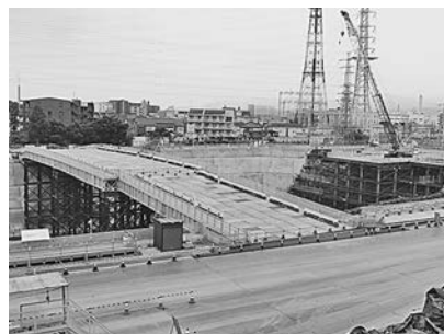
土留め壁利用と法面利用の箇所
