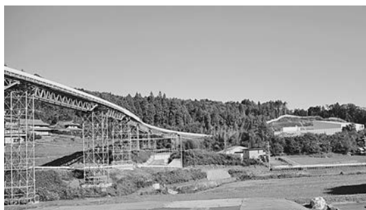
非常口掘削現場（右奥）とベルトコンベアが姿を現す
