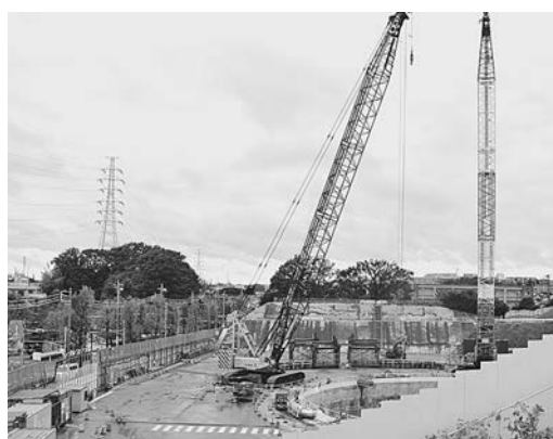
東百合ヶ丘非常口 立て抗掘削工事が進む
