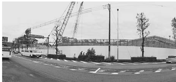
東百合ヶ丘非常口工事現場
