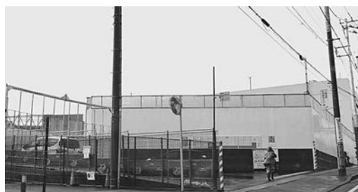
犬蔵非常口工事現場
